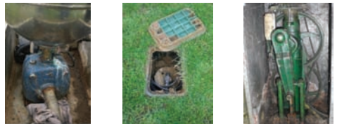
Figura 7. Pozos de barrena equipados con bombas centrífuga, sumergible y de émbolo
