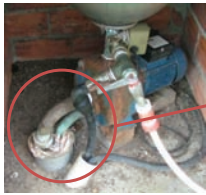
Detalle de mala práctica en el sellado de la boca del pozo
